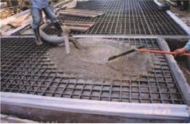
圖 6.2 澆注混凝土
